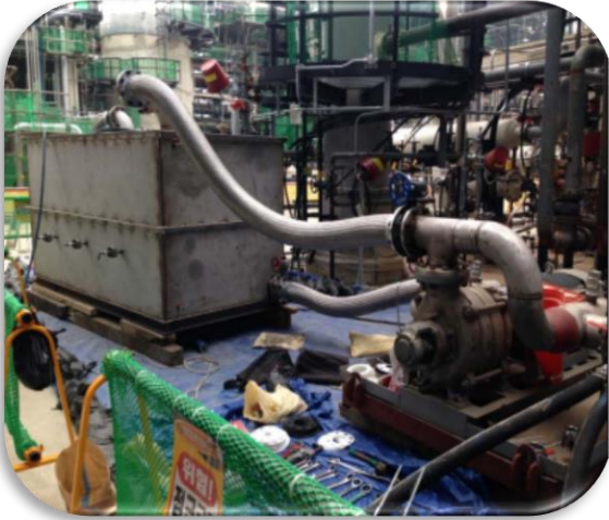
Chemical Pump 설치
