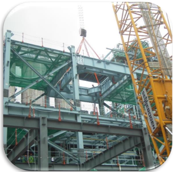
Module STR. Erection
