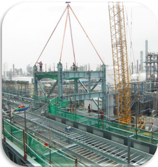
Module STR. Erection
